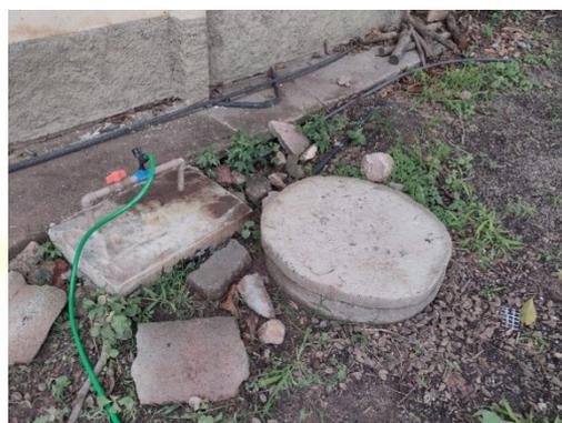
Toda hidráulica precisou ser refeita: trocamos a Caixa d'água, registro geral da casa, torneiras dos banheiros, canos, caixas de descarga. Fizemos, ainda, os tampões das caixas de esgoto que estavam abertas.
